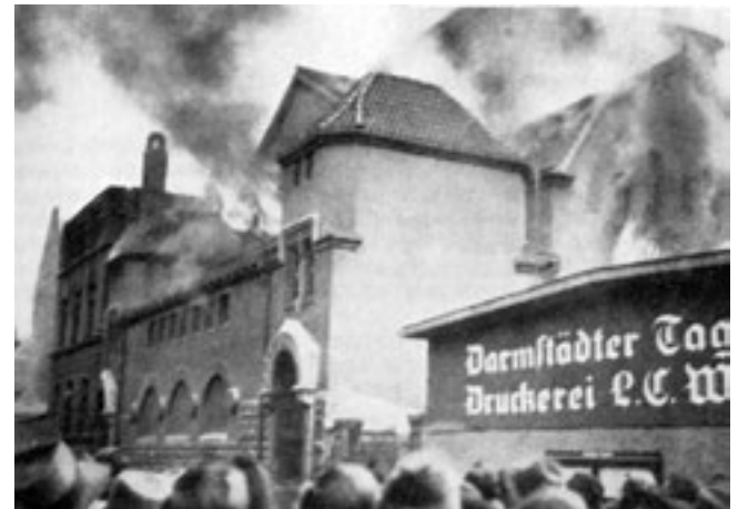
Brennende Orthodoxe Synagoge Bleichstraße neben dem TAGBLATT-Gebäude Foto: Stadtarchiv
